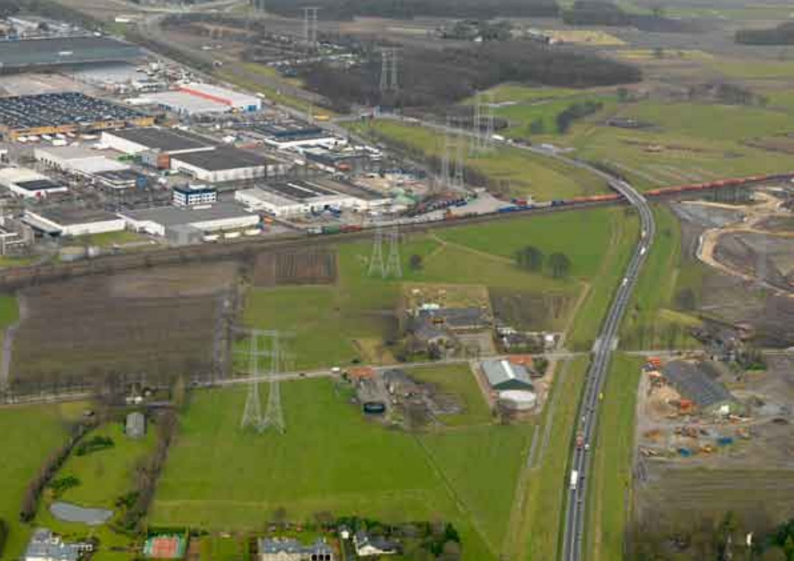
Hoogspanningsverbinding ten noorden van Tilburg (landelijke ring 380 kV).
